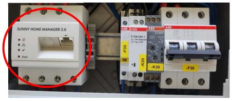
Hinweis: Drehmoment für Schraubklemmen des Smart Meter 2.0 = 2,0 Nm
